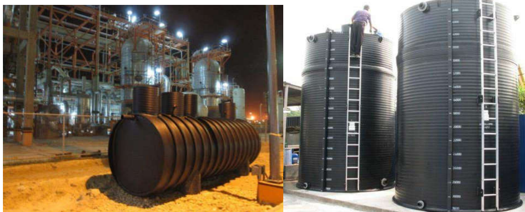
شکل (۵) نصب مخزن بر روی سطح زمین
