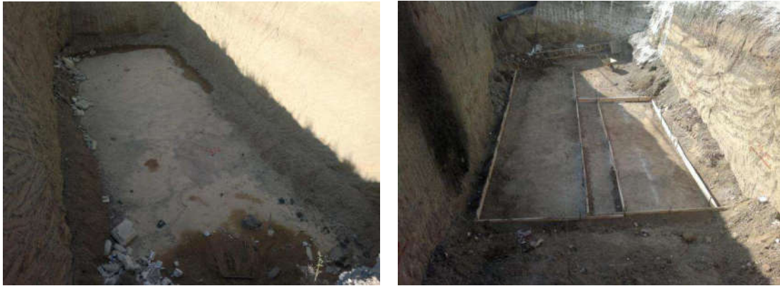
شکل (۱) خاکبرداری و اجرای بتن کف مخازن
