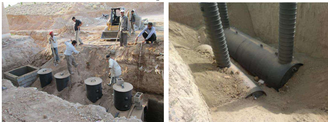
شکل (۴) پرکردن صحیح ترانشه
