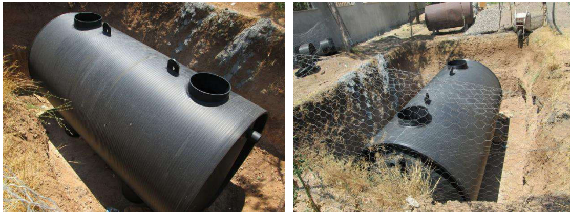
شکل (۳) جانمایی صحیح مخزن در ترانشه
